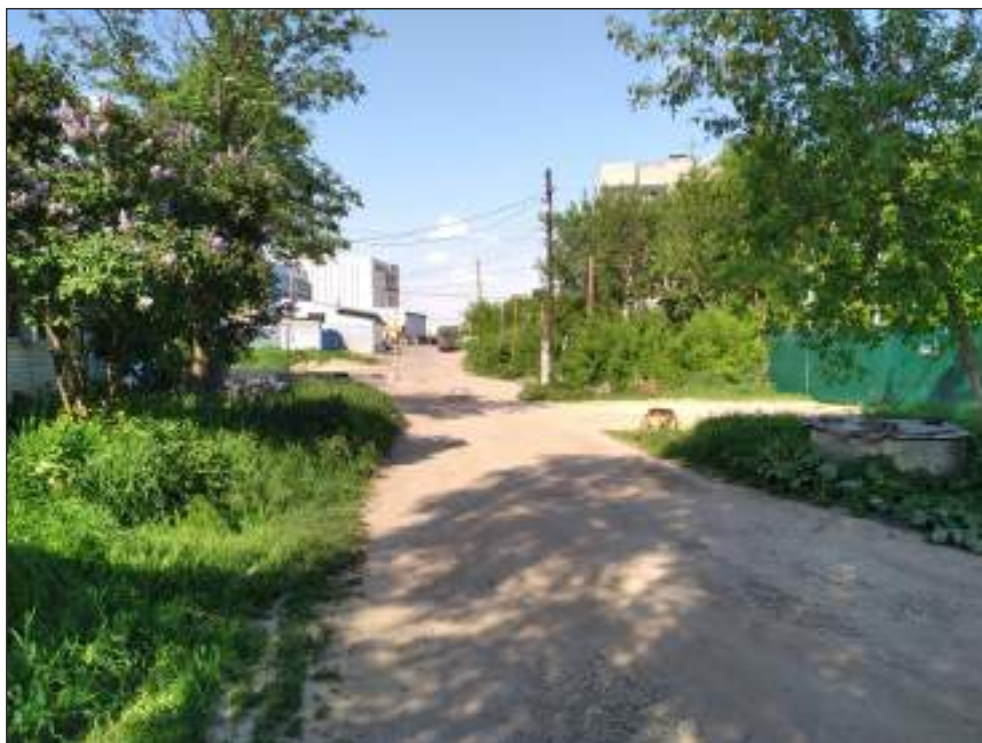
Илл. 22. Видовая фотофиксация трассы проектируемого объекта «Газопровод-ввод к жилому дому по адресу: Нижегородская область, Балахнинский район, г. Балахна, ул. Колёсная, д. 1Б» (Код объекта 152-22-102-041972). Точка фотофиксации 2. Вид с ЗЮЗ на трассу проектируемого газопровода
